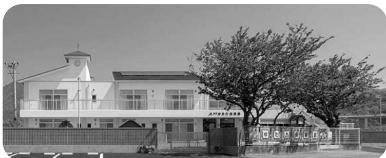
平成25年3月新園舎完成
